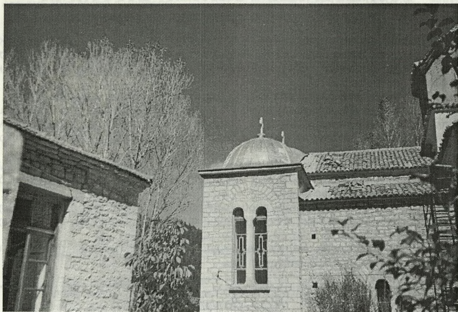
Από τις εργασίες επισκευής των τρούλων και της στέγης του Ιερού Ναού της Μεταμόρφωσης του Σωτήρος.
