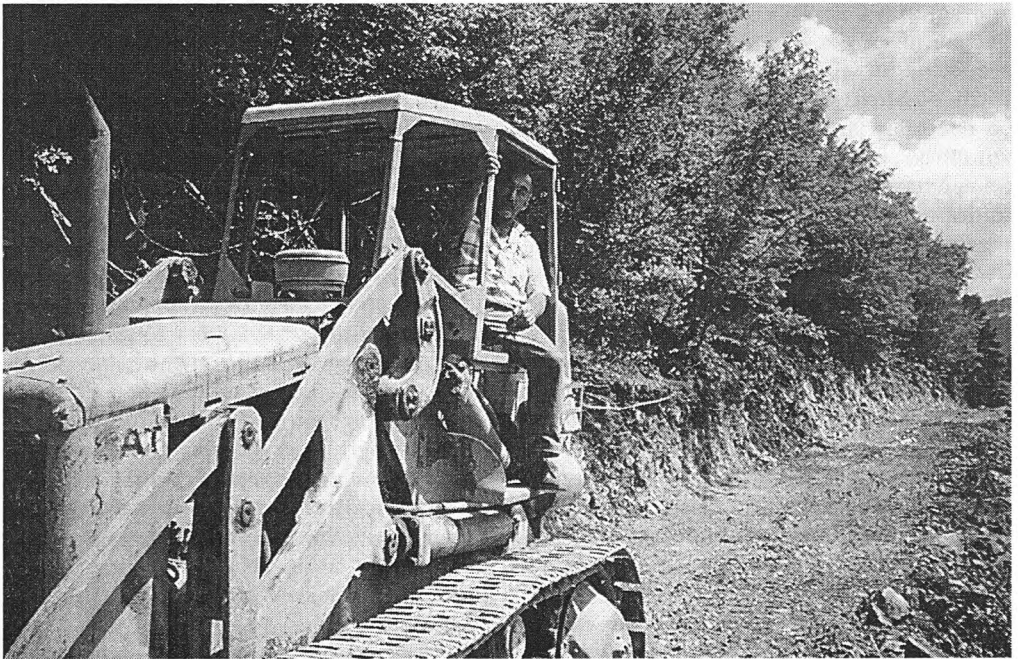
Σπ. Χατζόπουλος: Διάνοιξη του δρόμου-αυλακιού για την τοποθέτηση σωλήνων ύδρευσης Κεφαλοβρύσου νέου οικισμού.
