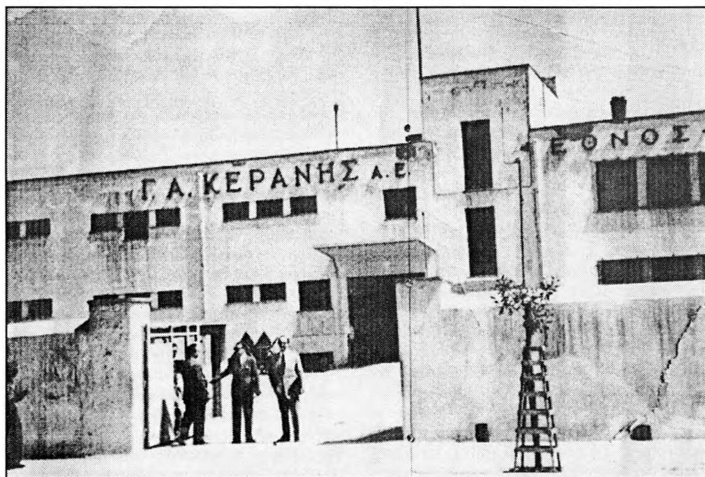
Το πρώτο κτίριο της καπνοβιομηχανίας Κεράνη
